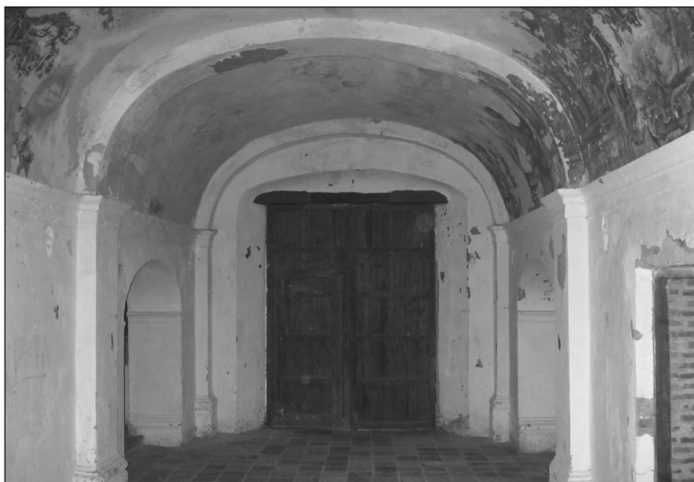
Figura 15. Interior de la iglesia de San Torcuato.
